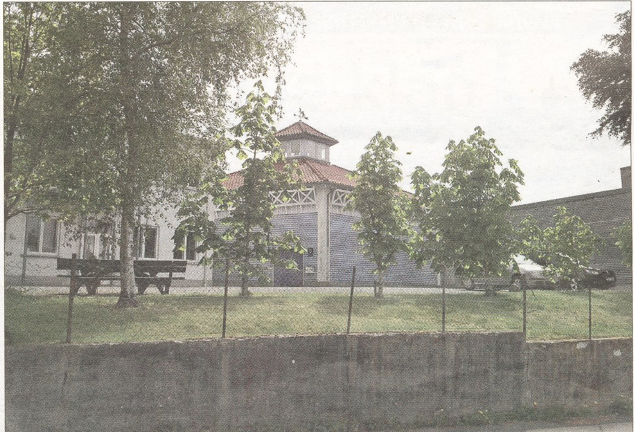
Den bedårende og – i Højbjergborgernes øjne – bevaringsværdige kunstbygning ”Den Blå Hest” på Heidesvej. Privatfoto .
